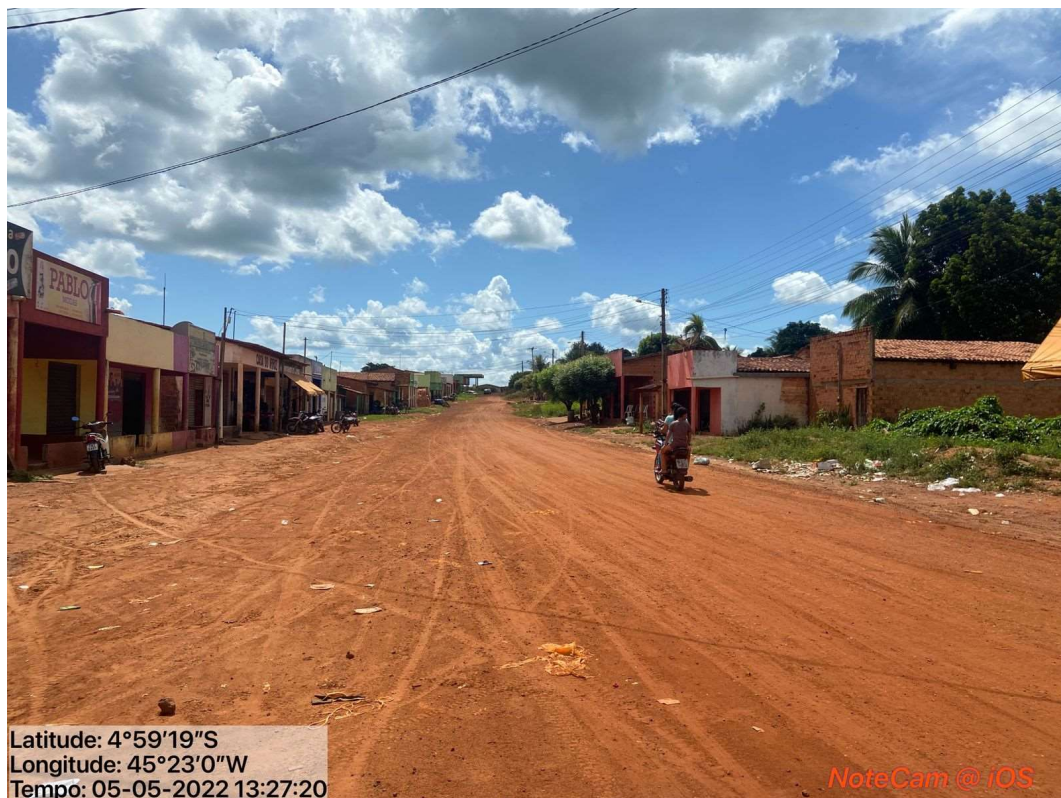
Foto 3: Av. Wilson Silva Após Rua da Estrela
