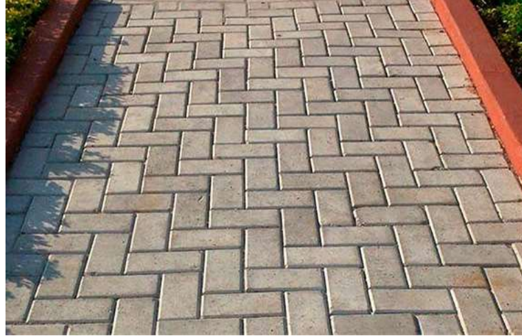
Figura 4: Disposição dos Blocos da Calçada “Espinha de Peixe”
