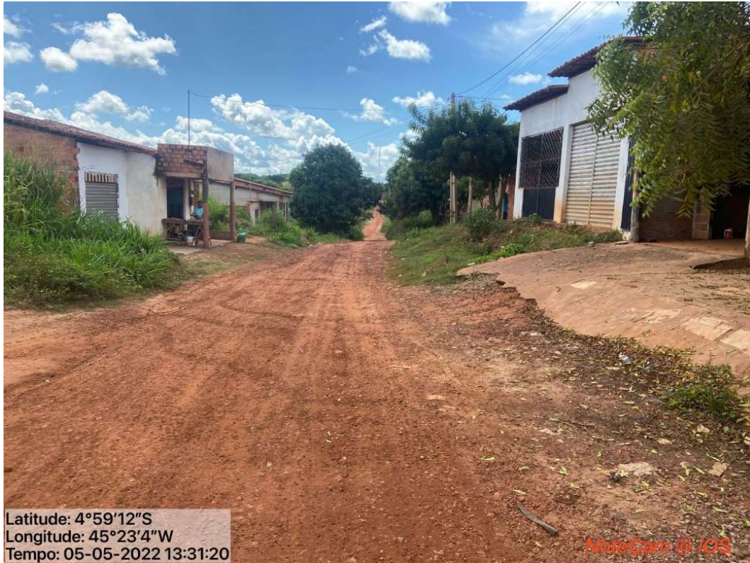
Foto 12: Final do Trecho (Continuação da Av. Wilson Silva, após Rua Projetada)
