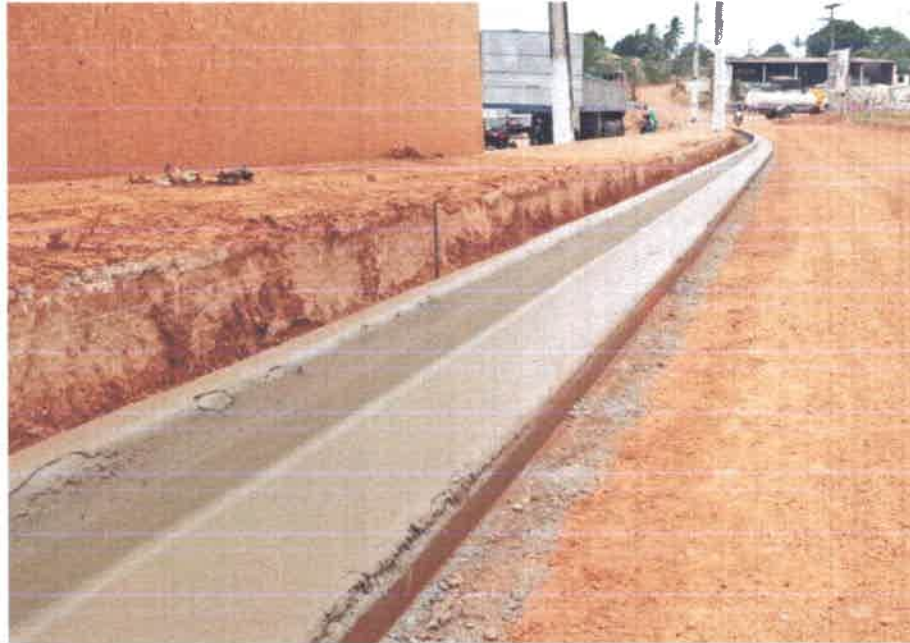
Figura 5: Meio-fio e sarjeta conjugados
