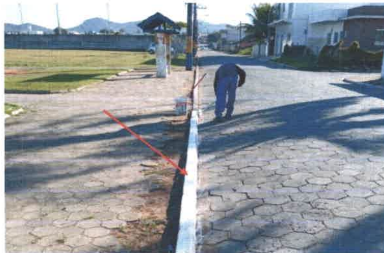
Figura 7: Pintura de Meio-Fio
