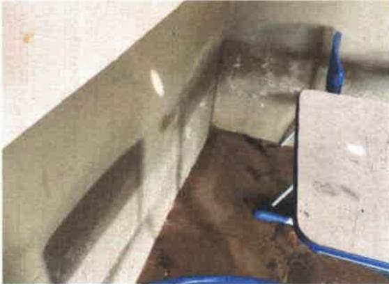
Foto 26: Reboco caído/ Alvenaria aparente
