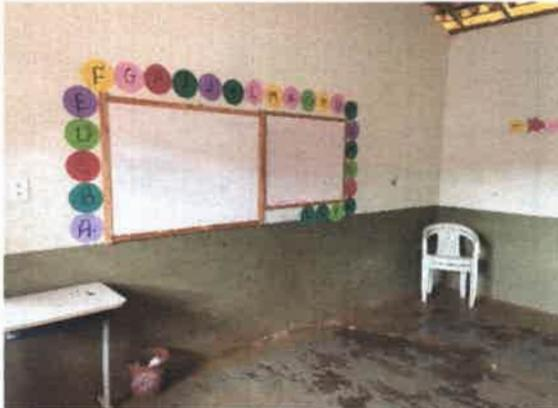
Foto 21: Piso e parede sem revestimento
