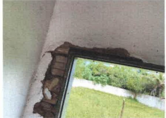
Foto 24: Infiltração em parede do corredor
