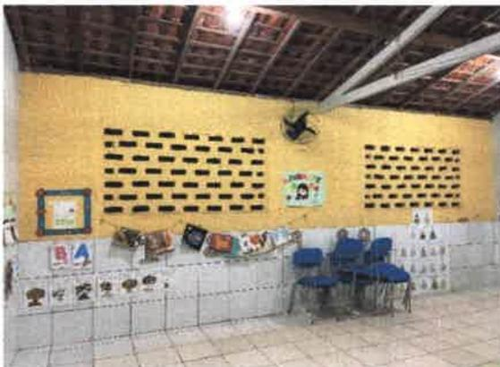
Foto 3: Telhado aparente (sala 01)
