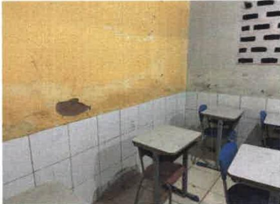
Foto 19: Infiltração na parede
