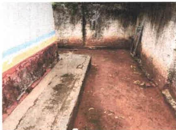
Foto 4: Calçada com trincas e rachaduras
