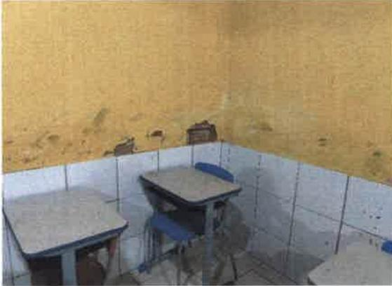
Foto 18: Infiltração na parede
