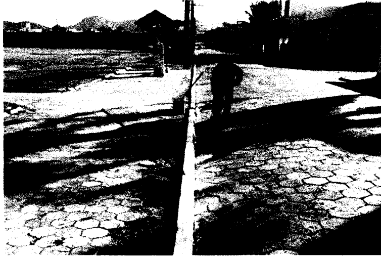
Figura 5: Pintura de Meio-Fio
