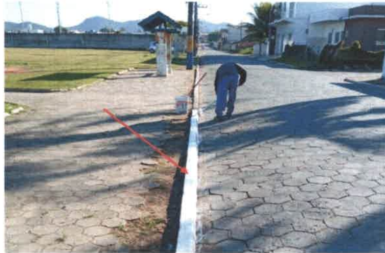
Figura 5: Pintura de Meio-Fio
