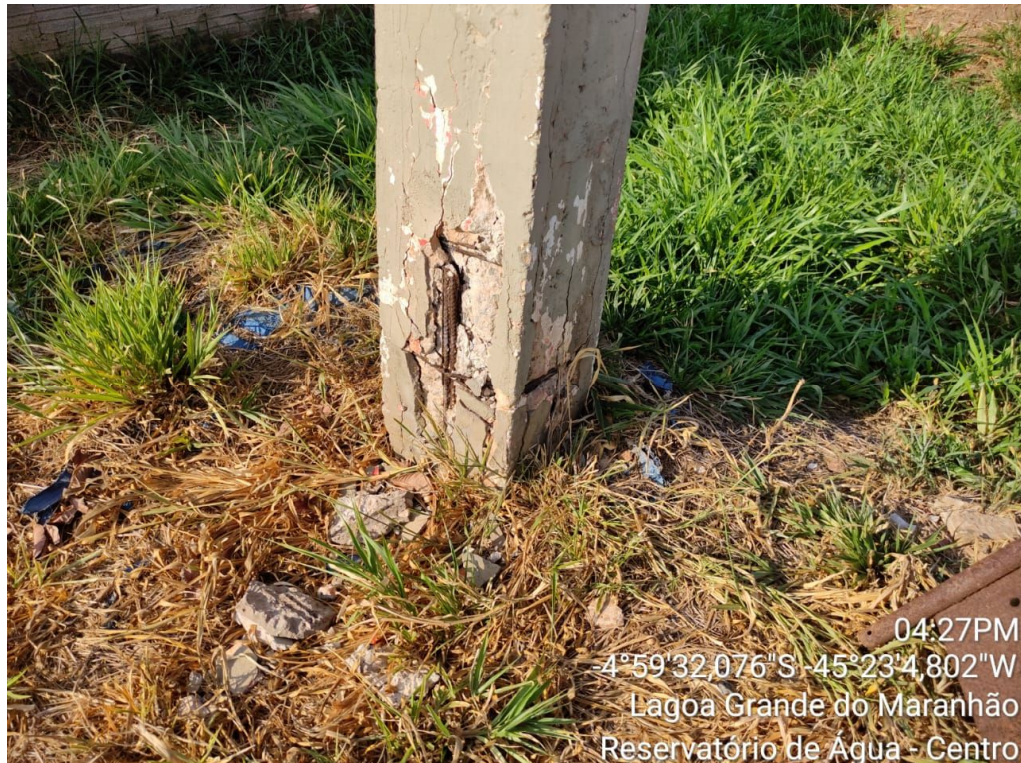
Imagem 5: Situação dos Pilares, trincas, exposição das armaduras.
