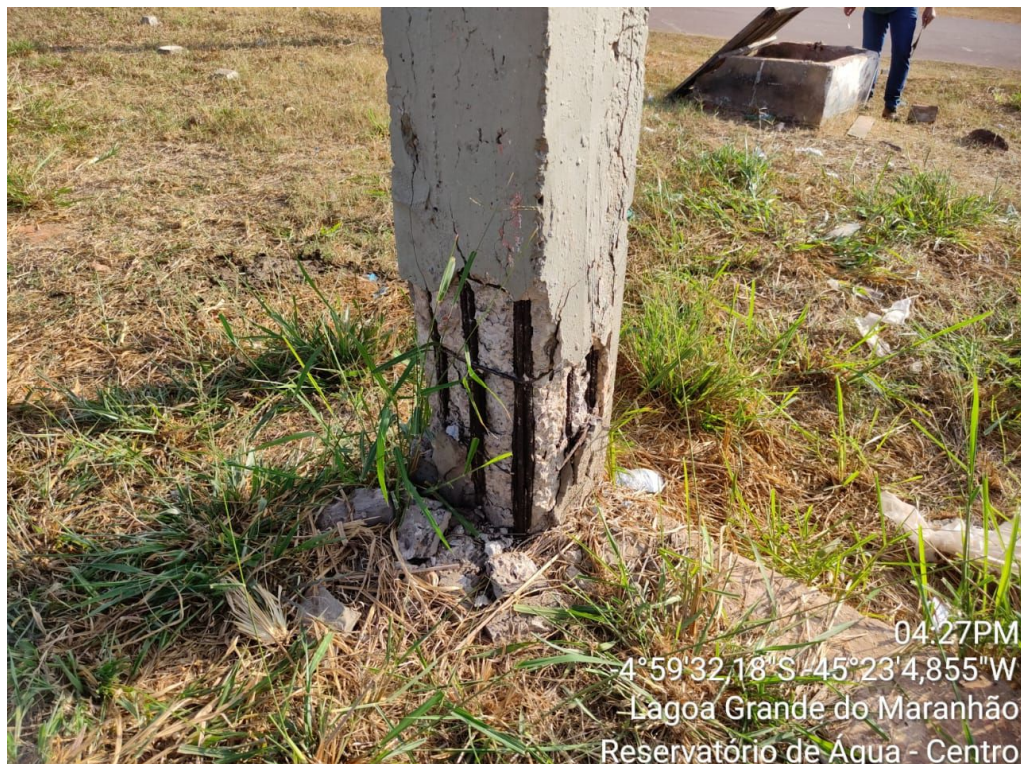
Imagem 5: Situação dos Pilares, trincas, exposição das armaduras.
