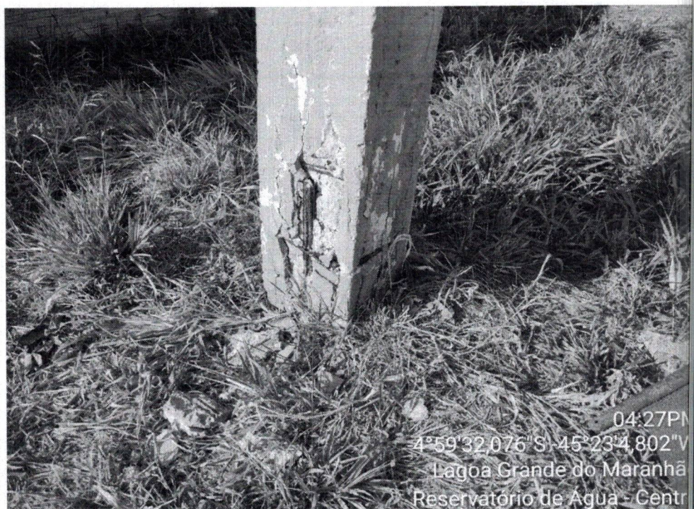
Imagem 5: Situação dos Pilares, trincas, exposição das armaduras.
