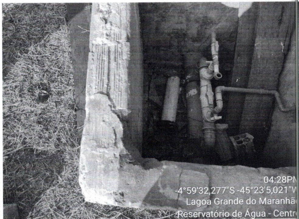
Imagem 8: Caixa do Clorador (desativado)
