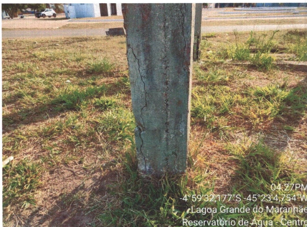
Imagem 3: R. Situação dos Pilares, trincas, exposição das armaduras.
