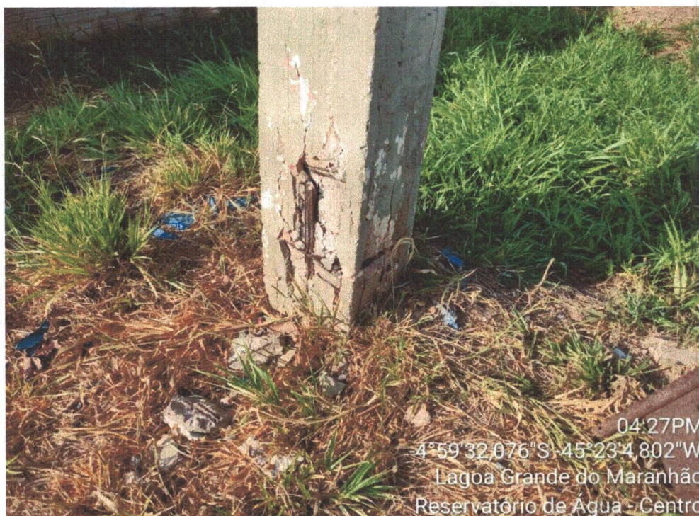
Imagem 5: Situação dos Pilares, trincas, exposição das armaduras.
