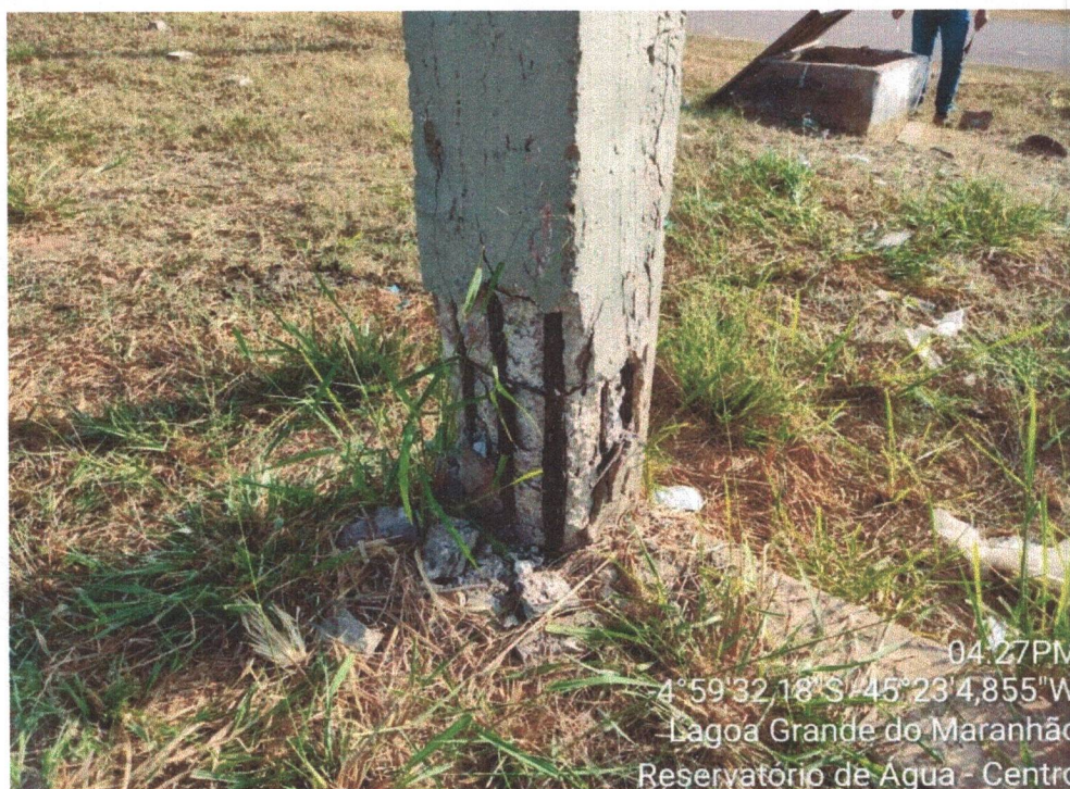
Imagem 5: Situação dos Pilares, trincas, exposição das armaduras.
