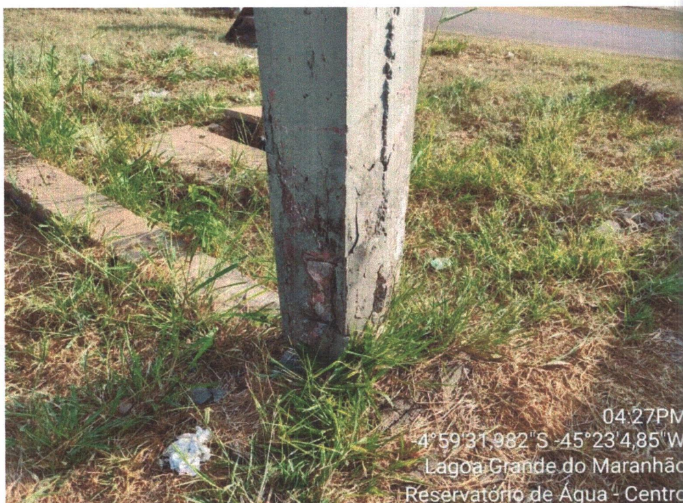
Imagem 3: R. Situação dos Pilares, trincas, exposição das armaduras.
