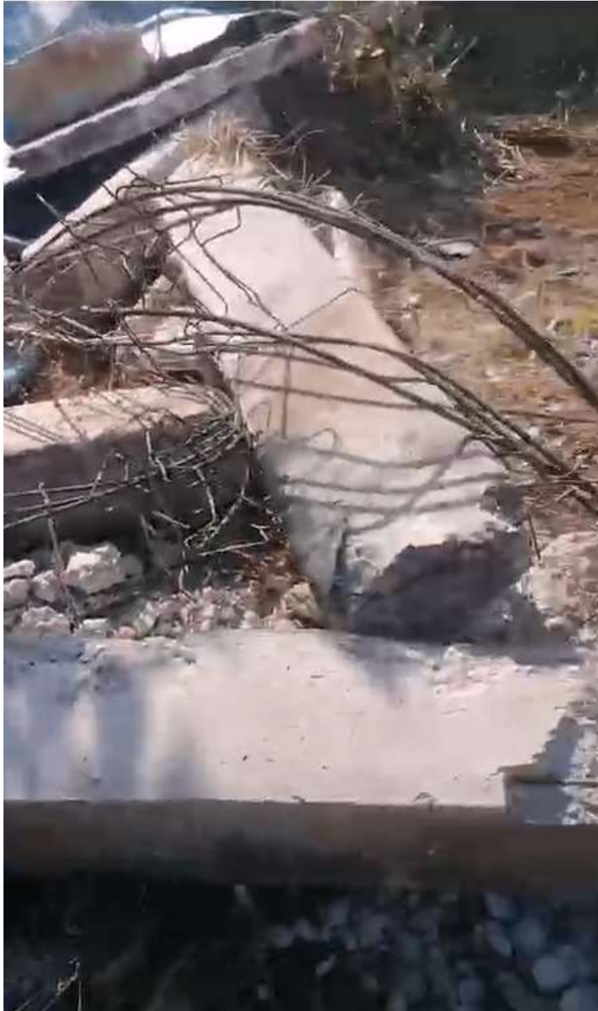
Foto 3: Pilares da estrutura atual
