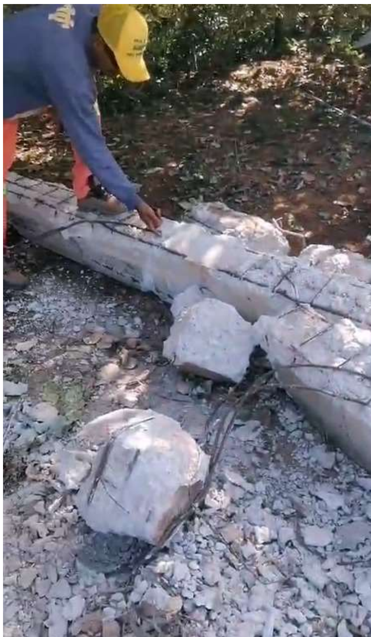
Foto 4: Pilares da estrutura atual
