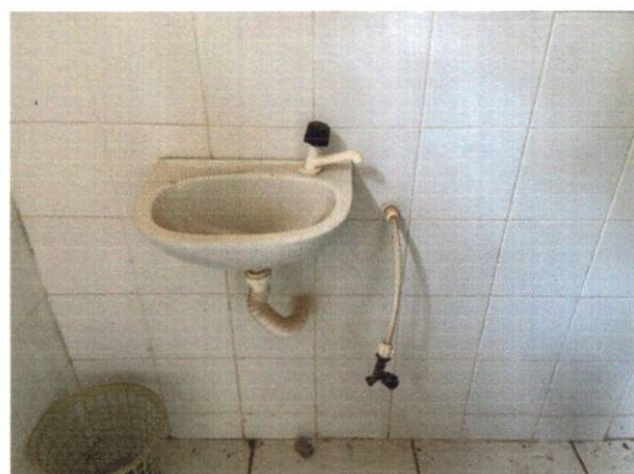
Figura 12: Lavatório Banheiro Feminino
