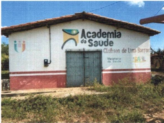
Figura 1: Fachada Norte (Entrada)
