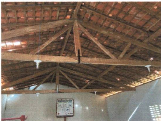
Figura 9: Madeiramento do telhado
