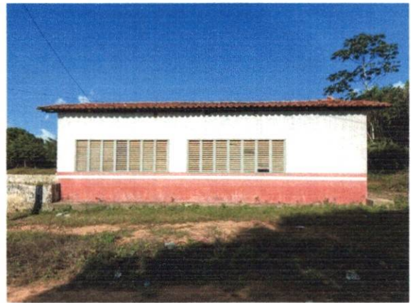
Figura 16: Fachada Lateral Oeste
