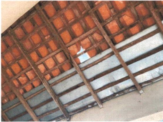
Figura 7: Telhado com aberturas
