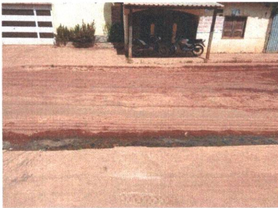
Figura 3: Rua João Gomes Carlota
