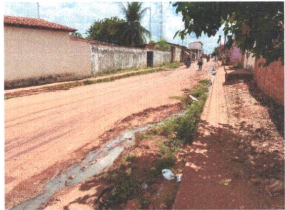
Figura 2: Rua São Francisco
