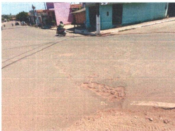
Figura 11: Rua São Francisco
