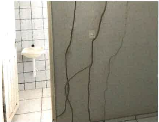
Figura 8: Porta cercada por cupim
