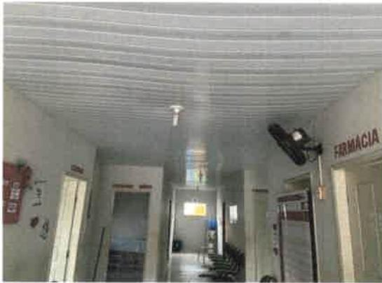
Figura 7: Forro Deformado
