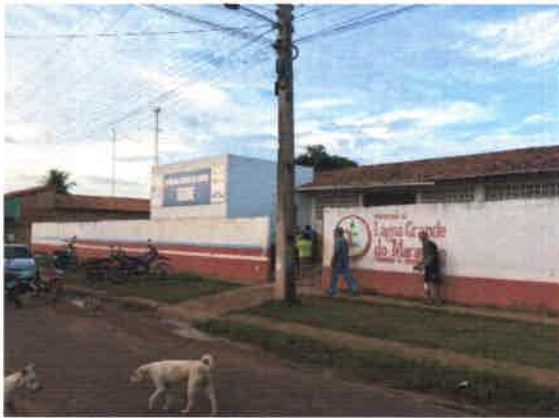
Figura 1: Fachada Norte (Entrada, Principal)
