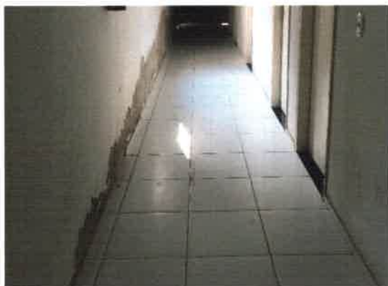
Figura 3: Rodapé e Piso do corredor
